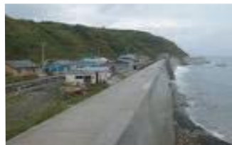
栈橋／港湾構造物など
