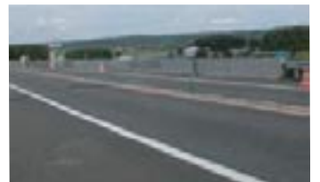
道路の壁高欄など
