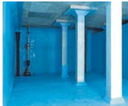
施工事例：池中野配水池（伊東市）
